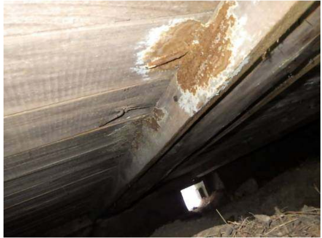
6. Lattiasieni keittiön avauskohdasta kuvattuna.
